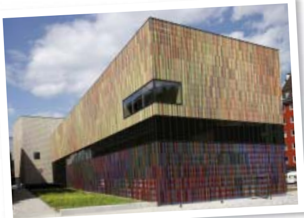
Außenfassade des Museum Brandhorst
